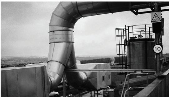
Der Luftbefeuchter soll die Prozess- oder Raumluft befeuchten und teilweise von Verschmutzungen wie Staub- und Fettpartikel befreien. Er wird üblicherweise zur Vorbereitung der Luft auf ein Bio-Filterbett verwendet. Außerdem arbeitet der Befeuchter als Luftkühlung, wenn warme Prozessluft in das Kanalsystem gelangen sollte.
