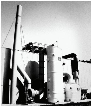
**Haarslev Scrubber sind Systeme für die Wäsche und chemische Oxidation von Luft und Gasen aus den Verarbeitungsmaschinen, um Gerüche zu reduzieren. Sie stellen einen wichtigen Anteil der Haarslev Lösungen zur Geruchsbeseitigung dar.**
