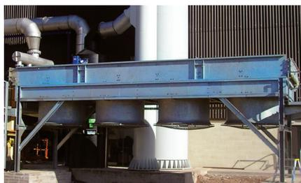
Alle Teile, die mit dem Dampf, dem Kondensat und/oder nicht kondensierbaren Gasen in Kontakt kommen, sind aus Edelstahl. Alle anderen Stahlteile sind aus feuerverzinktem Stahl oder Aluminium.
