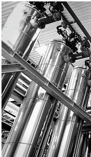
**Der Haarslev Shell & Tube Condenser kondensiert die Prozessdämpfe aus Kochern und Trocknern indirekt mit Wasser. Haarslev bietet eine vollständige Palette an solchen Rohrbündelkondensatoren für vielfältige Kapazitätsanforderungen.**
